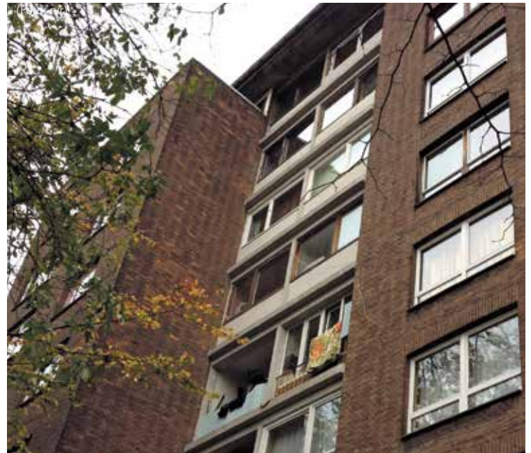
Das Haus In den Peschen 3-5 im Duisburger Stadtteil Rheinhausen soll bis Februar geräumt werden. (Foto: mac)
