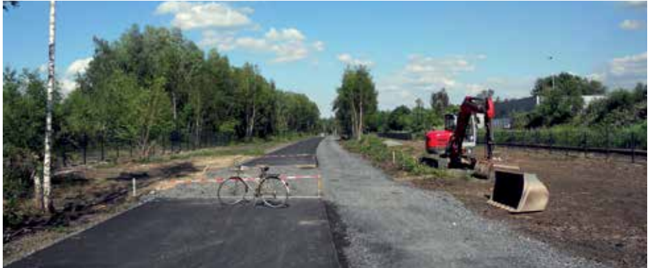
Der erste Streckenabschnitt in Mülheim steht kurz vor der Vervollendung. (Foto: tdk)
