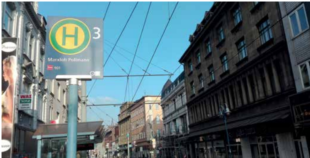
In Duisburg-Marxloh wurden mehrere Häuser geräumt, weil sie nicht mehr bewohnbar seien. Kritiker*innen sprechen von rabiatem Vorgehen der Stadt. (Foto: fro)
