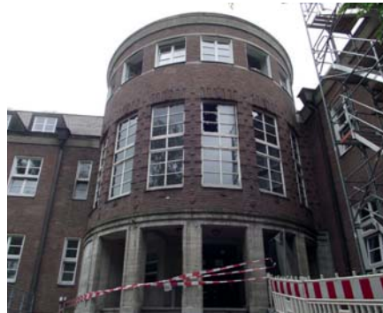
Opfer der Flammen: das LF-Gebäude (Foto: fro)
